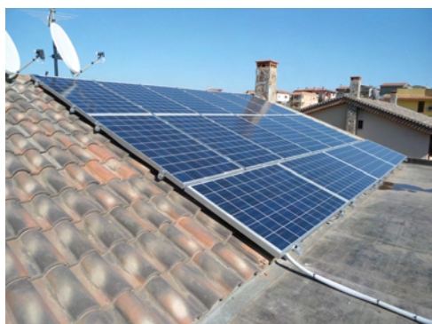
Impianti su edificio tipologia 2 (complanari al tetto)
