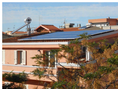
Impianti su edificio tipologia 2 (complanari al tetto)
